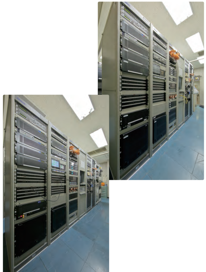
AV-HS7300シリーズのメインフレーム、ルーティングスイッチャー AV-WM7400 など (左：Bスタジオ用、右：Cスタジオ用)
